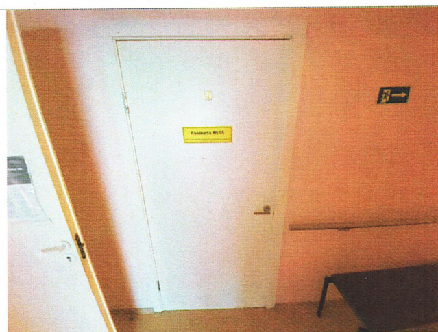
Фото №27 – Пути движения внутри здания (двери)
