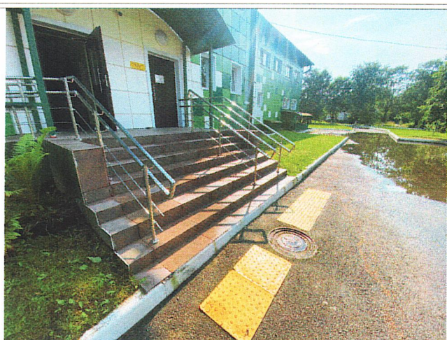
Фото №40 – Наружная лестница.
