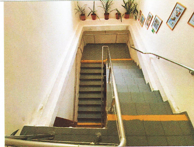
Фото №22 – Пути движения внутри здания (лестницы)
