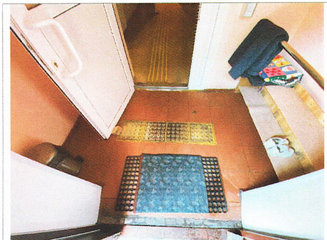
Фото №14 – Тамбур. Установлена тактильная плитка.
