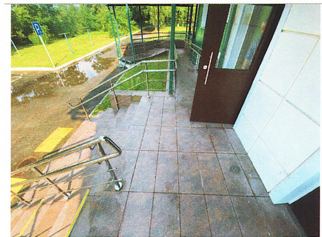
Фото №43– Входная площадка.
