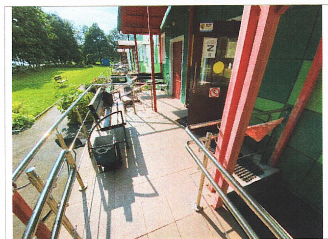
Фото №11 – Входная площадка.
