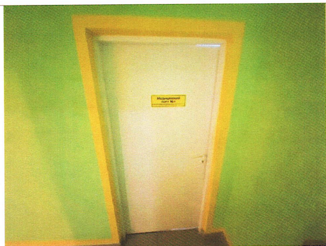
Фото №25 – Пути движения внутри здания (двери)
