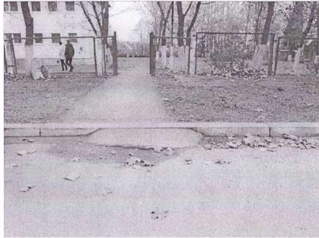
Фото №2 – Вход на прилегающую территорию
