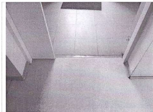
Фото №11 – Внутренняя входная дверь
