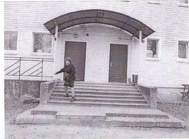
Фото №20 - Запасной (эвакуационный) выход
