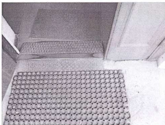
Фото №9 – Наружная входная дверь
